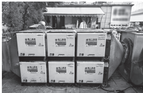
图1 改造后租赁的油烟净化设备
