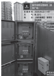
图 1 加装智能电源监控模块
