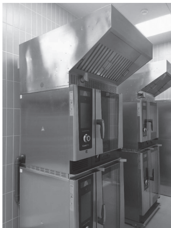
图 1 设备安装实景
