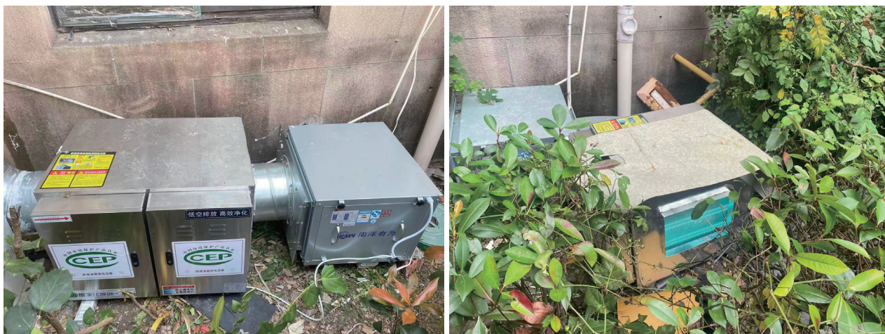
图1 为商家被投诉后责令加装的油烟净化器以及商家为了更高效地去除油烟味于7月底加装的UV光解光氧除味净化器
